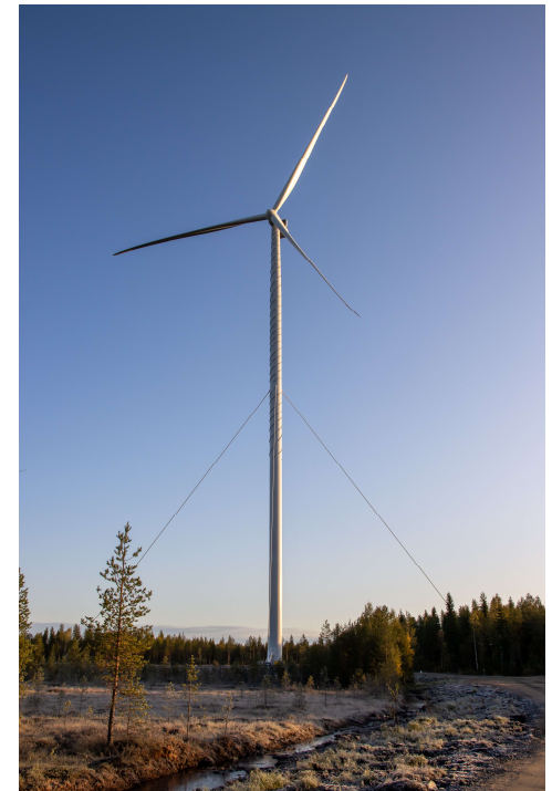
Kuva: TuuliWatti Oy
