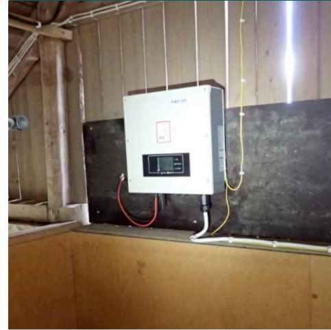
Invertteri palavalla alustalla ja etäisyydet liian pienet
