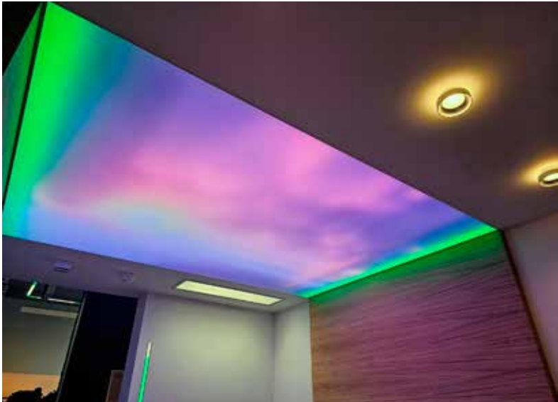
Heräämön katon valopaneeli. Valaismien malli on Cieluma.
